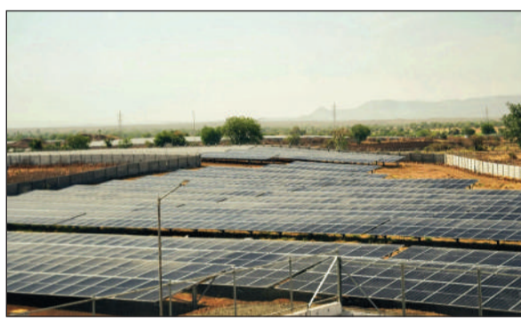
जलूद सोलर पावर प्लांट
